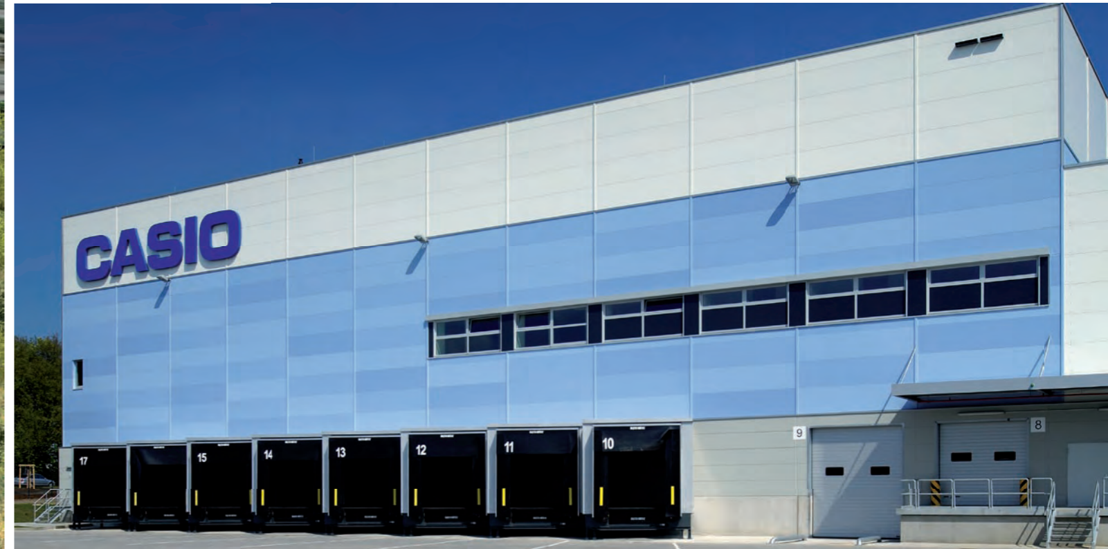
Der Wareneingang in das Hochregallager mit einer Gesamtkapazität von 15.000 Europalettenplätzen erfolgt über acht LKW-Andockstationen.
