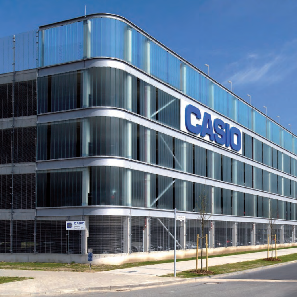
Ausgeführt als Split-Level-Bauwerk, bietet das Parkhaus mit seiner charakteristischen Fassade aus Glaselementen und Metallgittern Platz für 270 Fahrzeuge.
