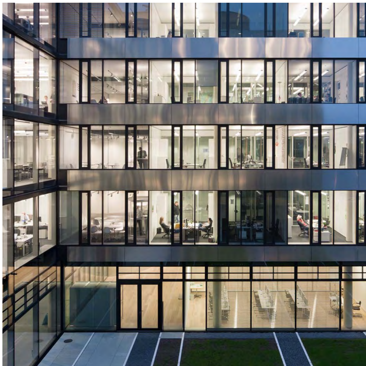
Offene Kommunikation in allen sechs Etagen: Das neue Verwaltungsgebäude bietet moderne, ökologische und menschenfreundliche Arbeitsplätze mit flexiblen Strukturen.
