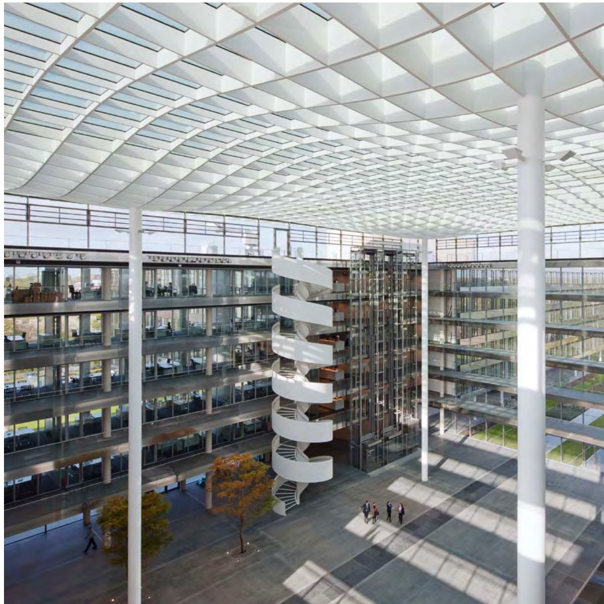
Vom Glasdach überspannt, von Wendeltreppen flankiert: Das Herz der Verwaltungszentrale ist das raumhohe Atrium mit seiner filigranen Dachkonstruktion aus Stahl und Glas.
